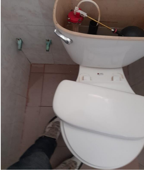
Chequeo y reparación de baños:
