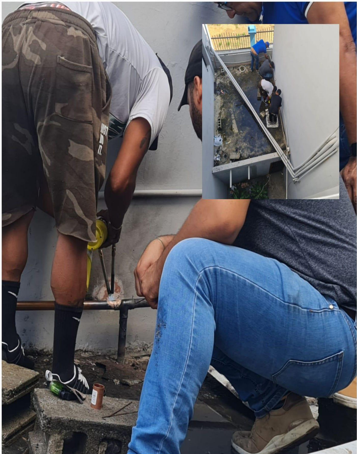
Mantenimiento tuberías de Oxígeno
