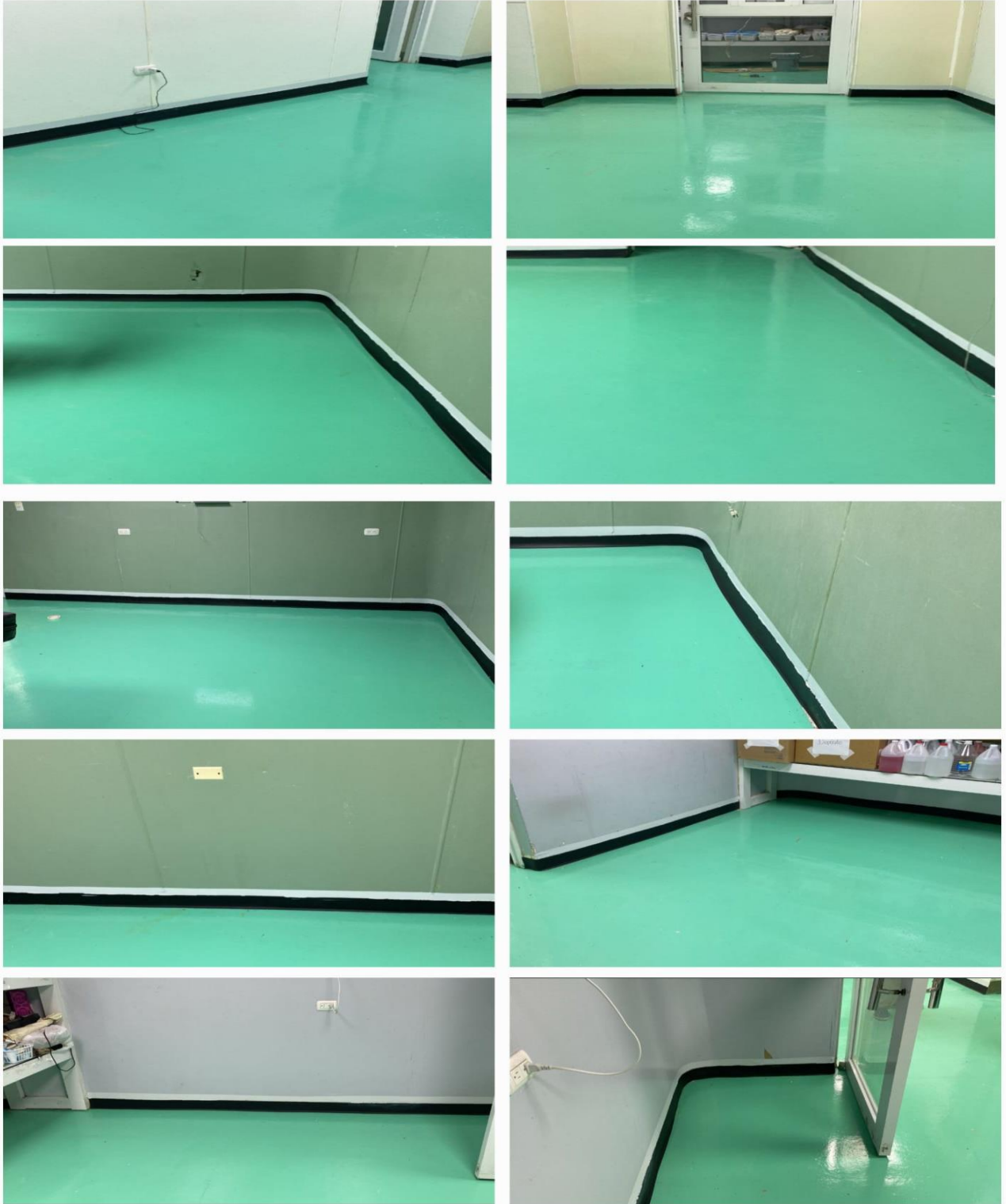
Colocación de Sócalos Quirófanos de Cirugía General (Ahora)
