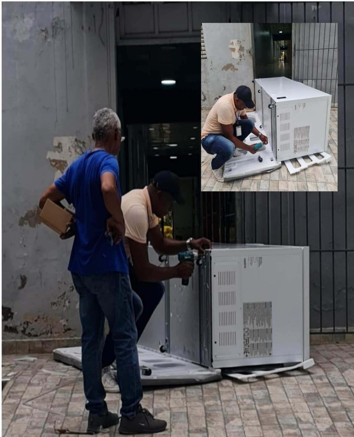
Mantenimiento de Refrigeración
