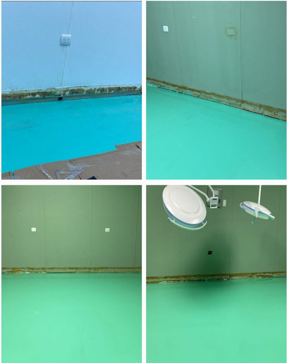
Colocación de Sócalos Quirófanos de Cirugía General (Antes)
