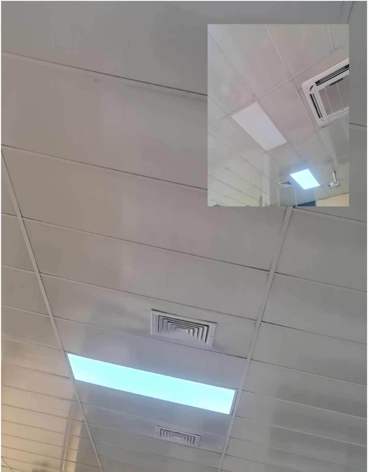
Cambio de Lámparas de Techo Salón Conferencia Tercer Nivel Maternidad
