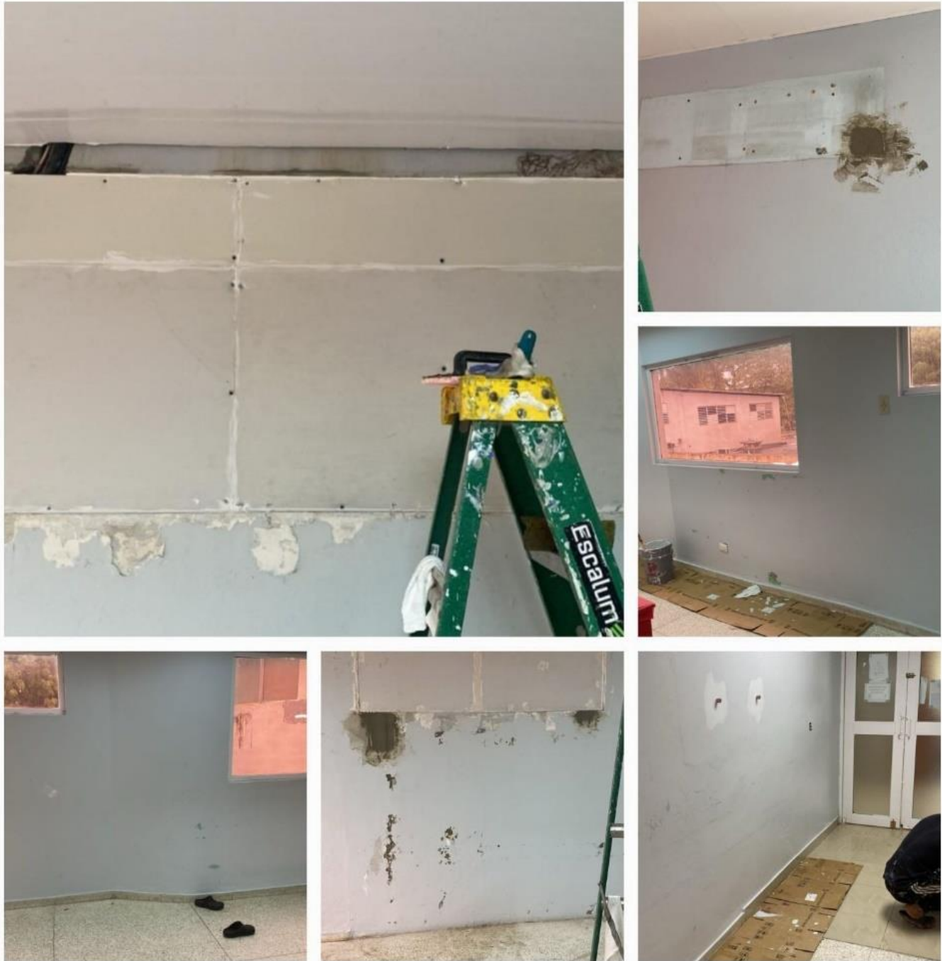
Pintura Pasillo Quirófanos de Cirugía General (Antes)
