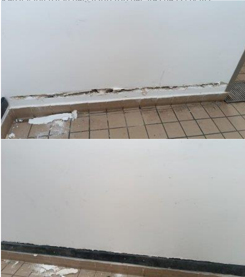
Reparación pared del cuarto frío del área de la cocina
