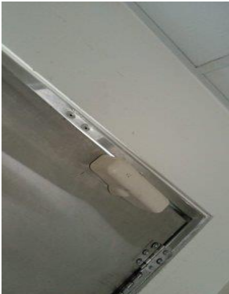
Reparación brazo de la puerta de emergencia
