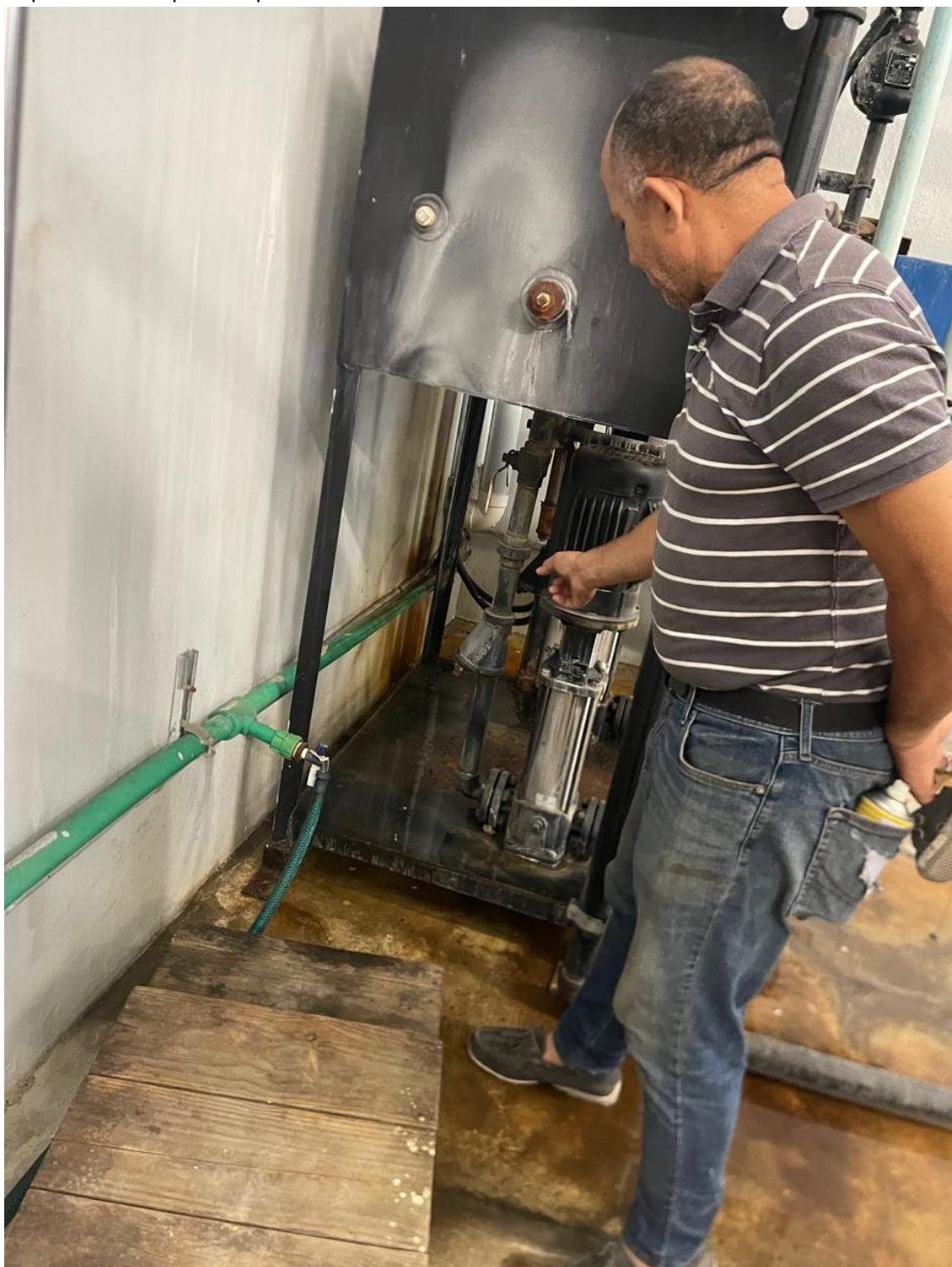
Reparación trampa de vapor en la caldera
