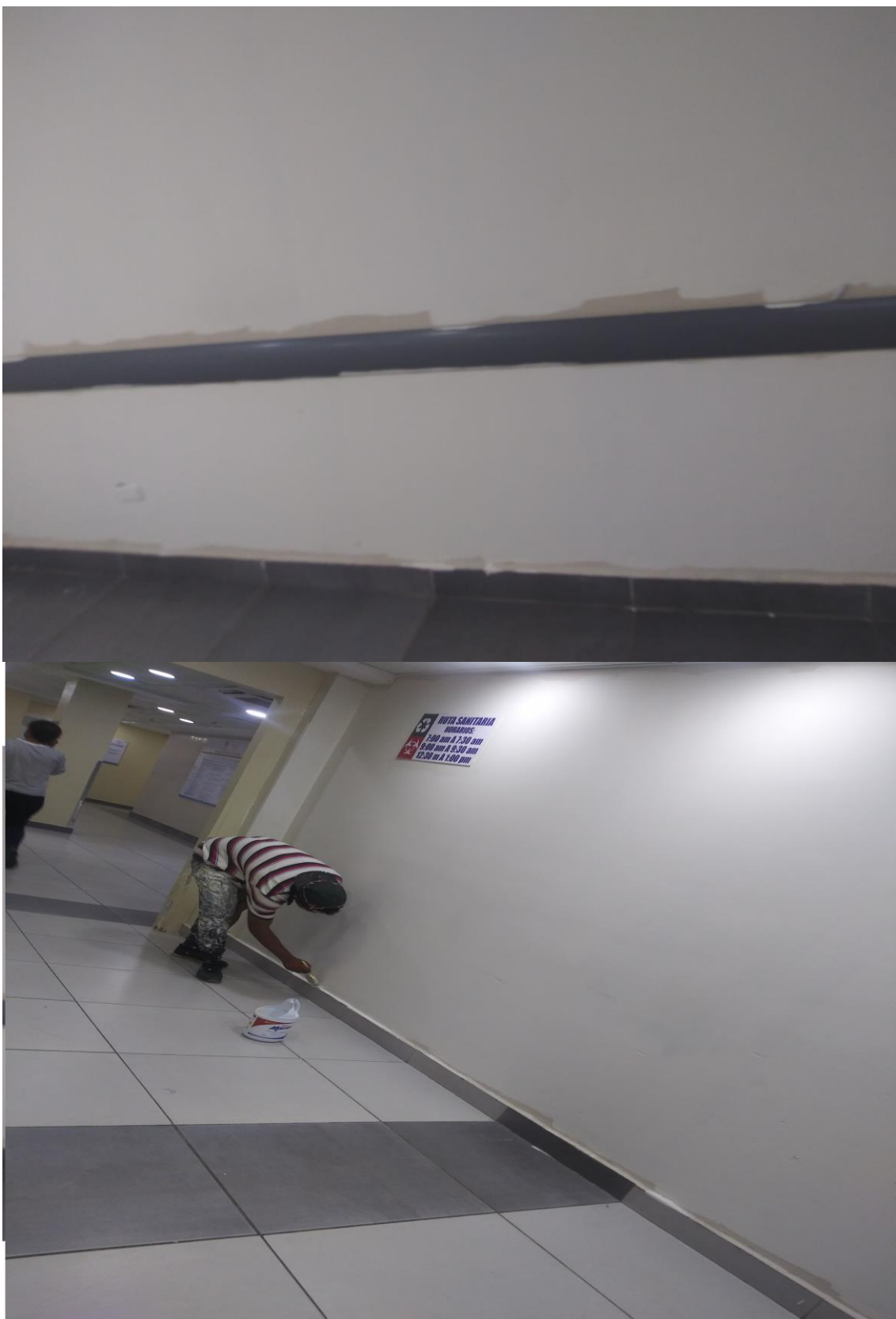
Reparación y pintura pasillo 4ta sur.
