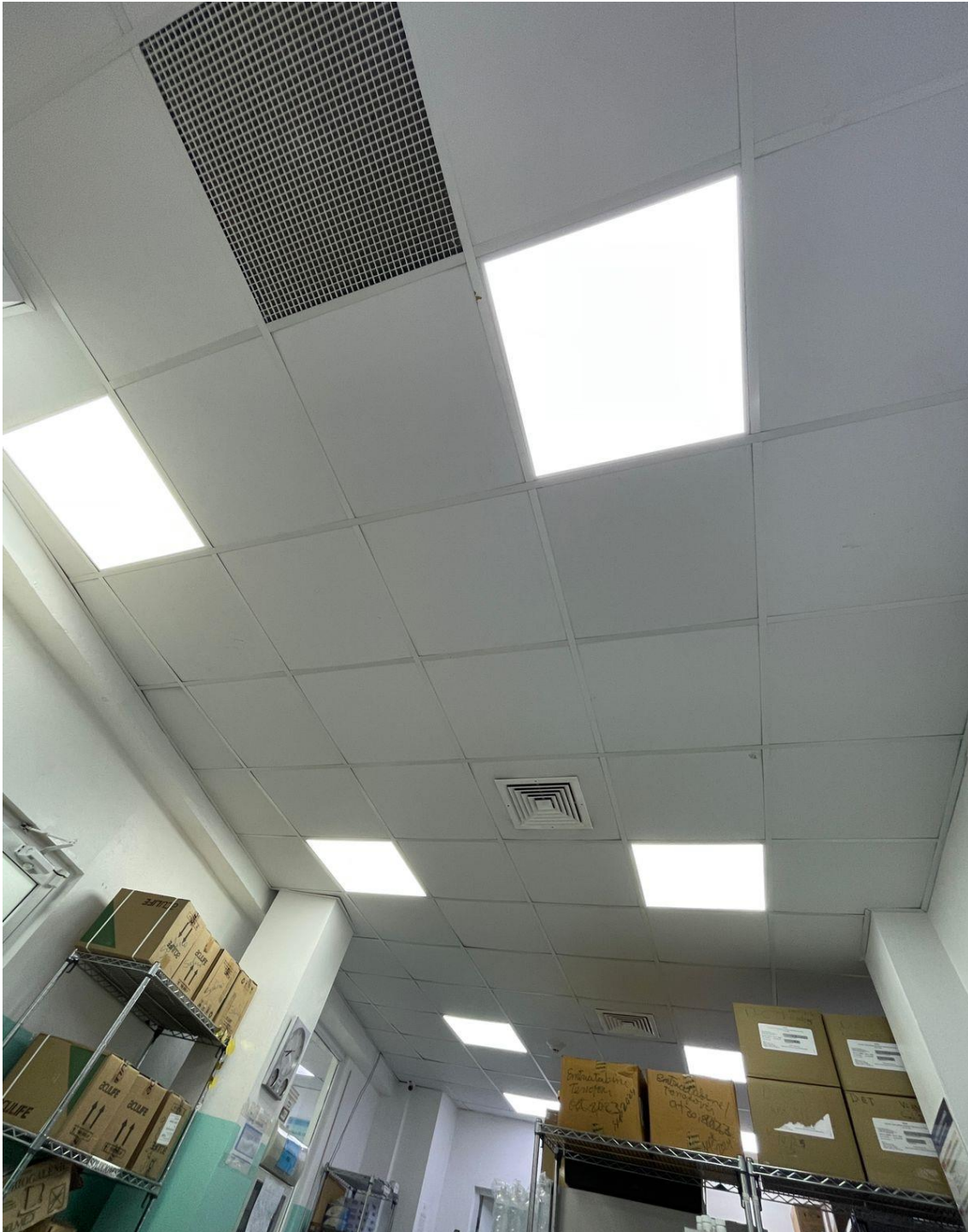
Imagen 25, techos sin filtraciones y buena iluminación.
