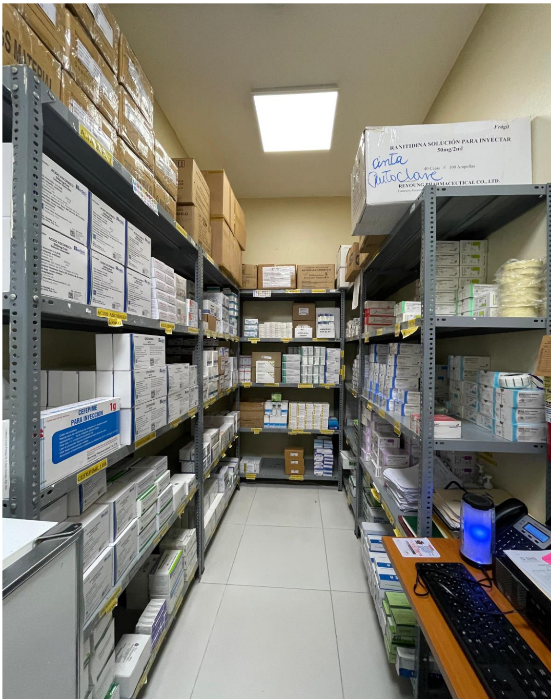
Imagen 9.1, techo limpio y sin filtraciones.
