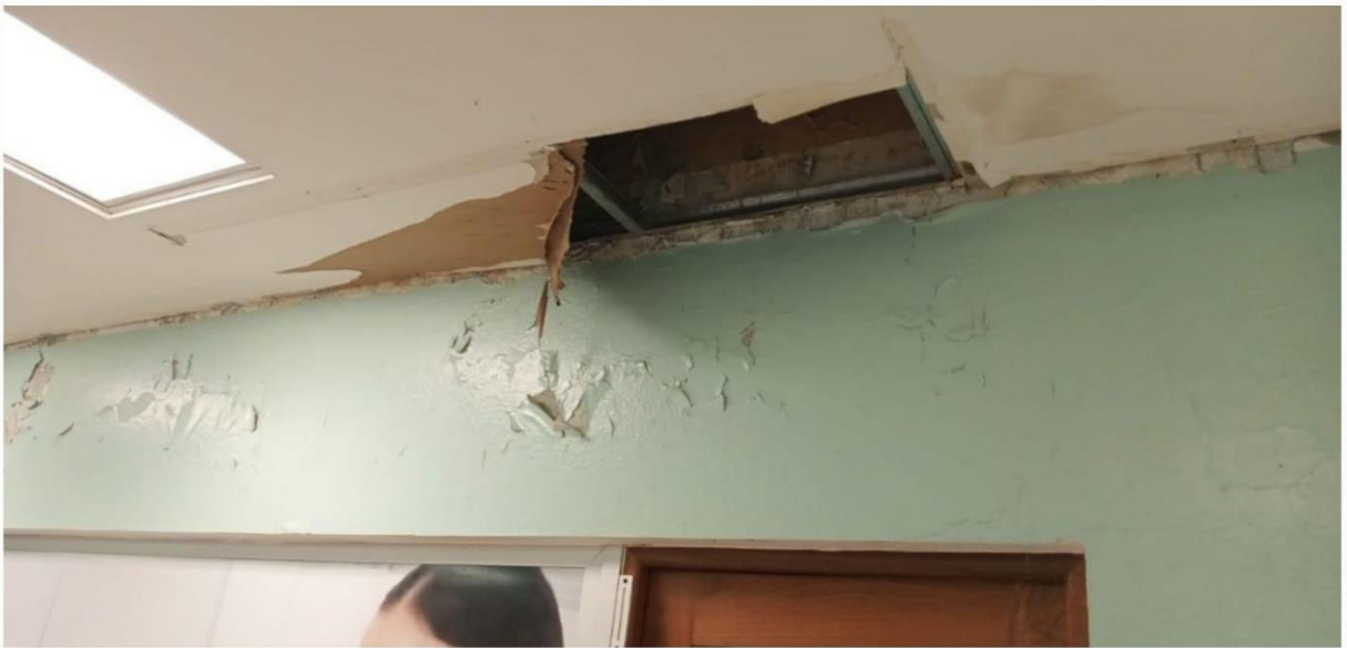
Reparación de Techo Area de Sonografía (Antes)
