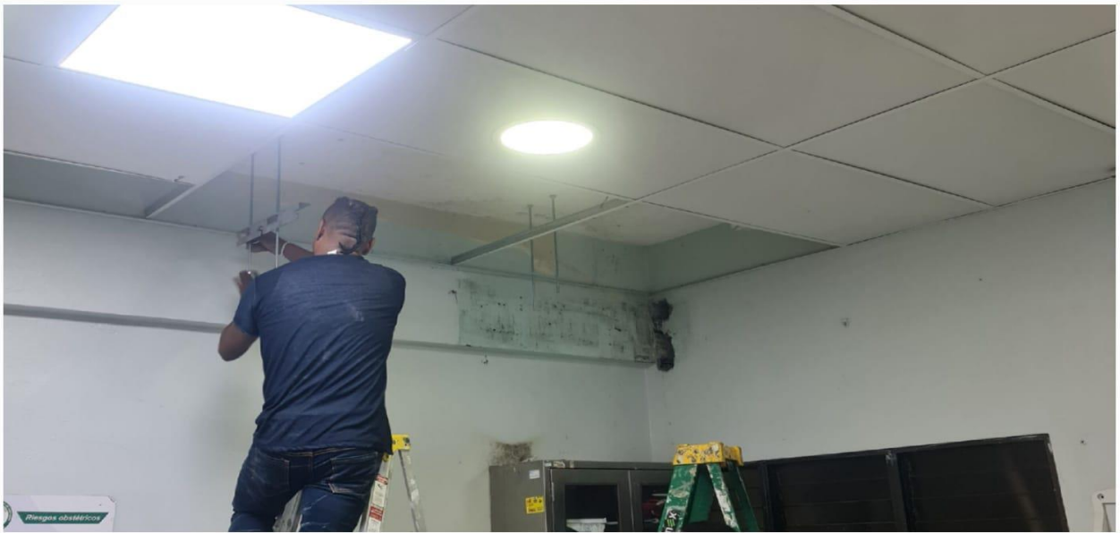
Mantenimiento de Aires Acondicionados de diferentes áreas
