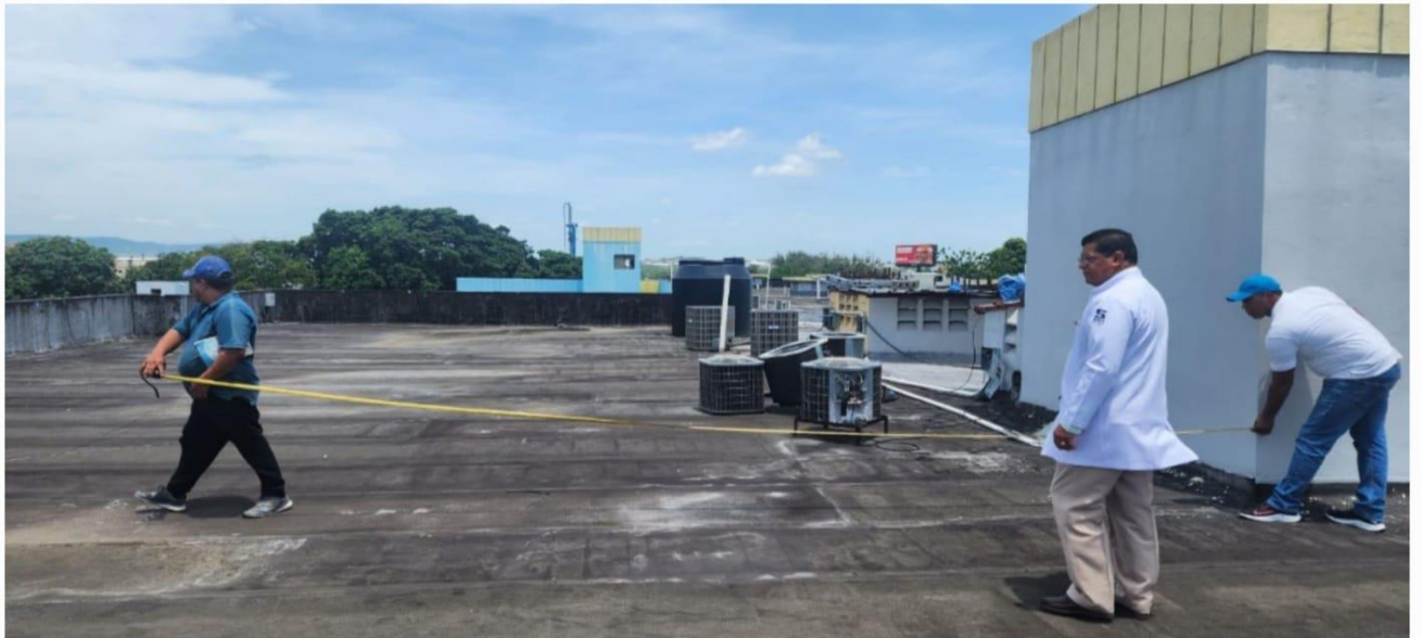
Reparación de Techos (Antes)
