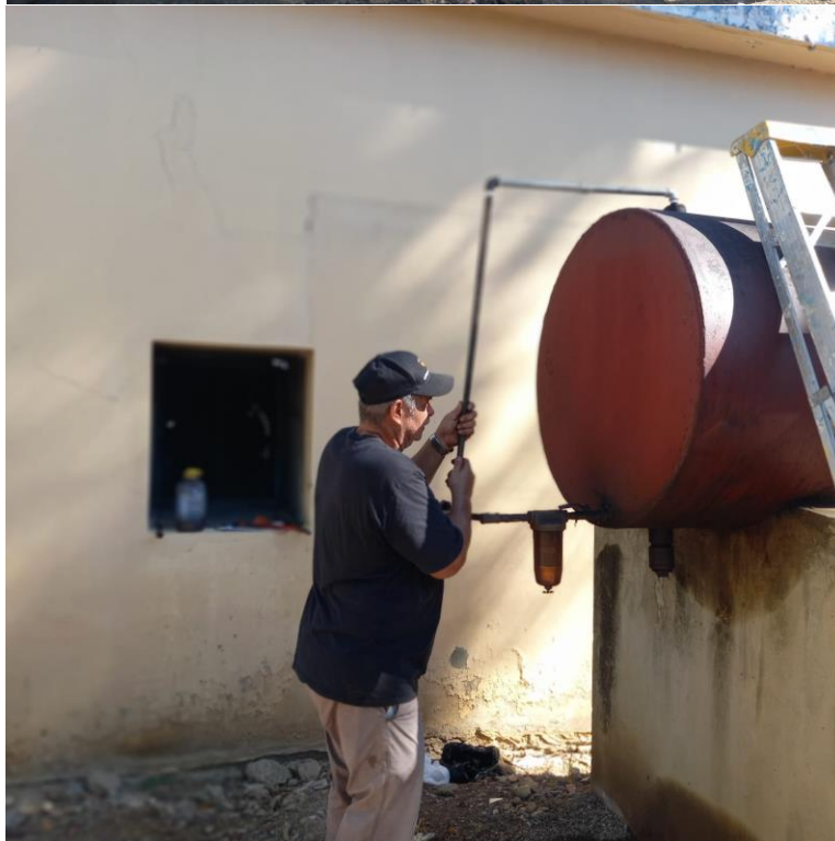
Cambio tubería de gasoil del tanque de la planta eléctrica, en fecha 23/01/2024
