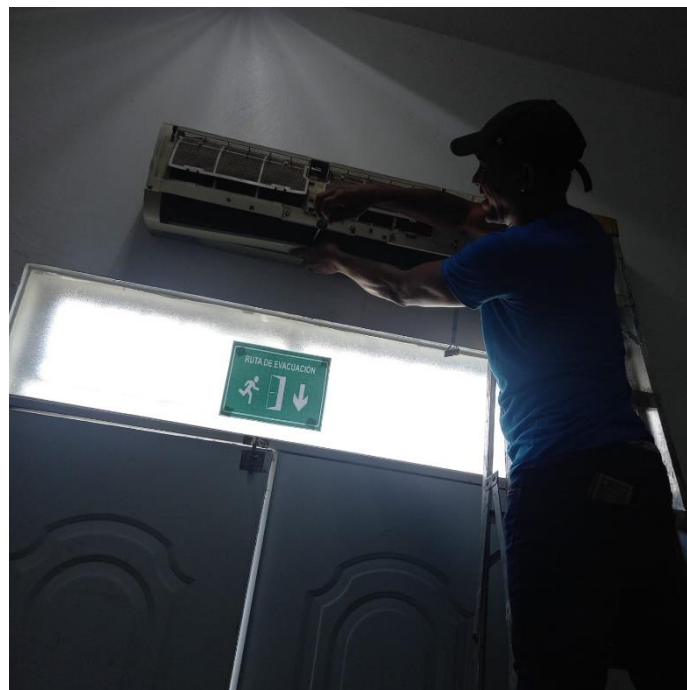
Lavado de filtros y cambio de refrigerantes de los aires de la maternidad, en fecha 24/01/2024
