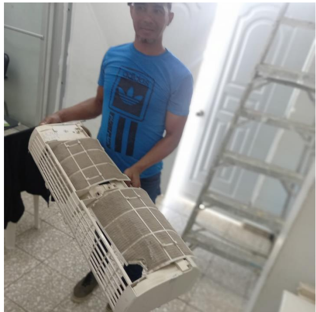
Lavado de filtros y cambio de refrigerantes de los aires de la maternidad, en fecha 24/01/2024
