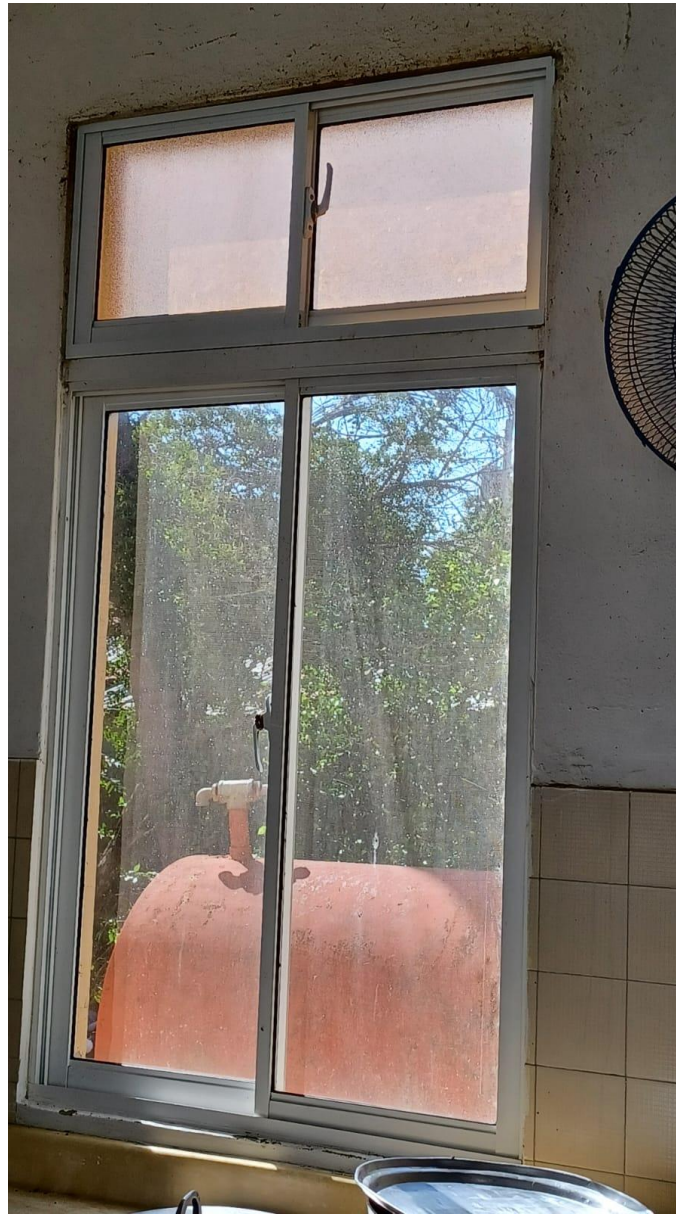
Cambio ventanal de la cocina en fecha 25/01/2024
