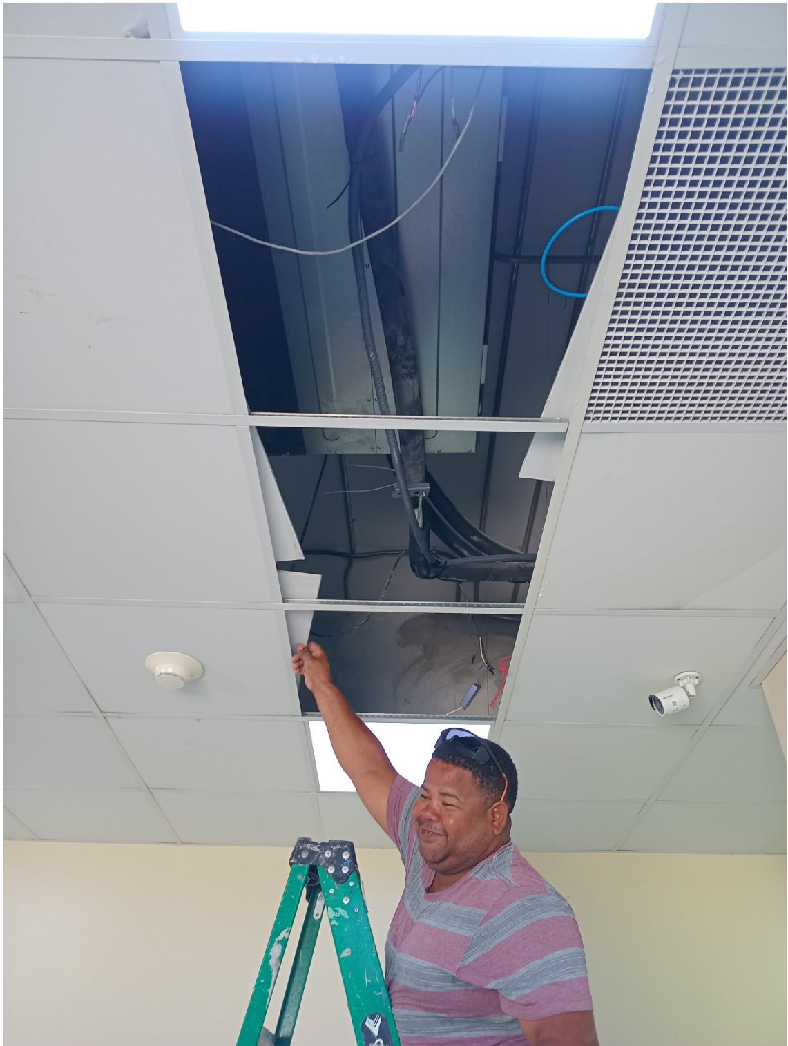
Reparación de aire de vacuna
