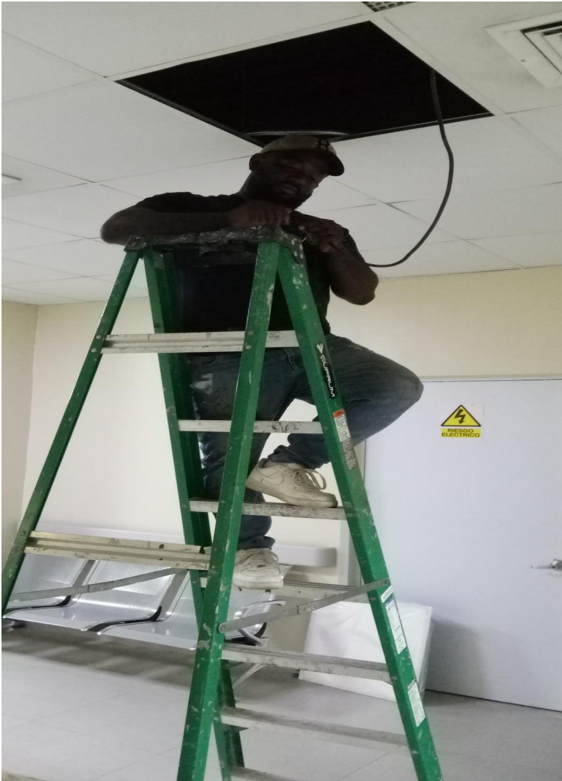
CAMBIO DE LAMPARA PASILLO DE INTERNAMIENTO
