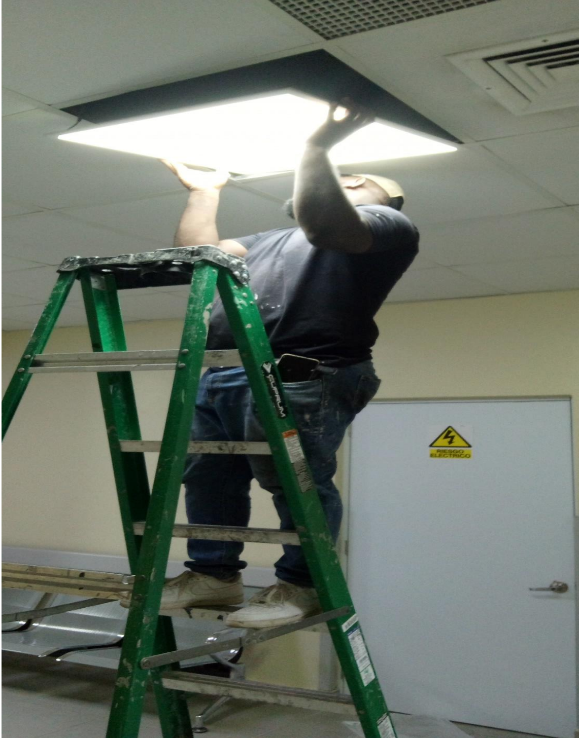
CAMBIO DE LAMPARA PASILLO DE INTERNAMIENTO
