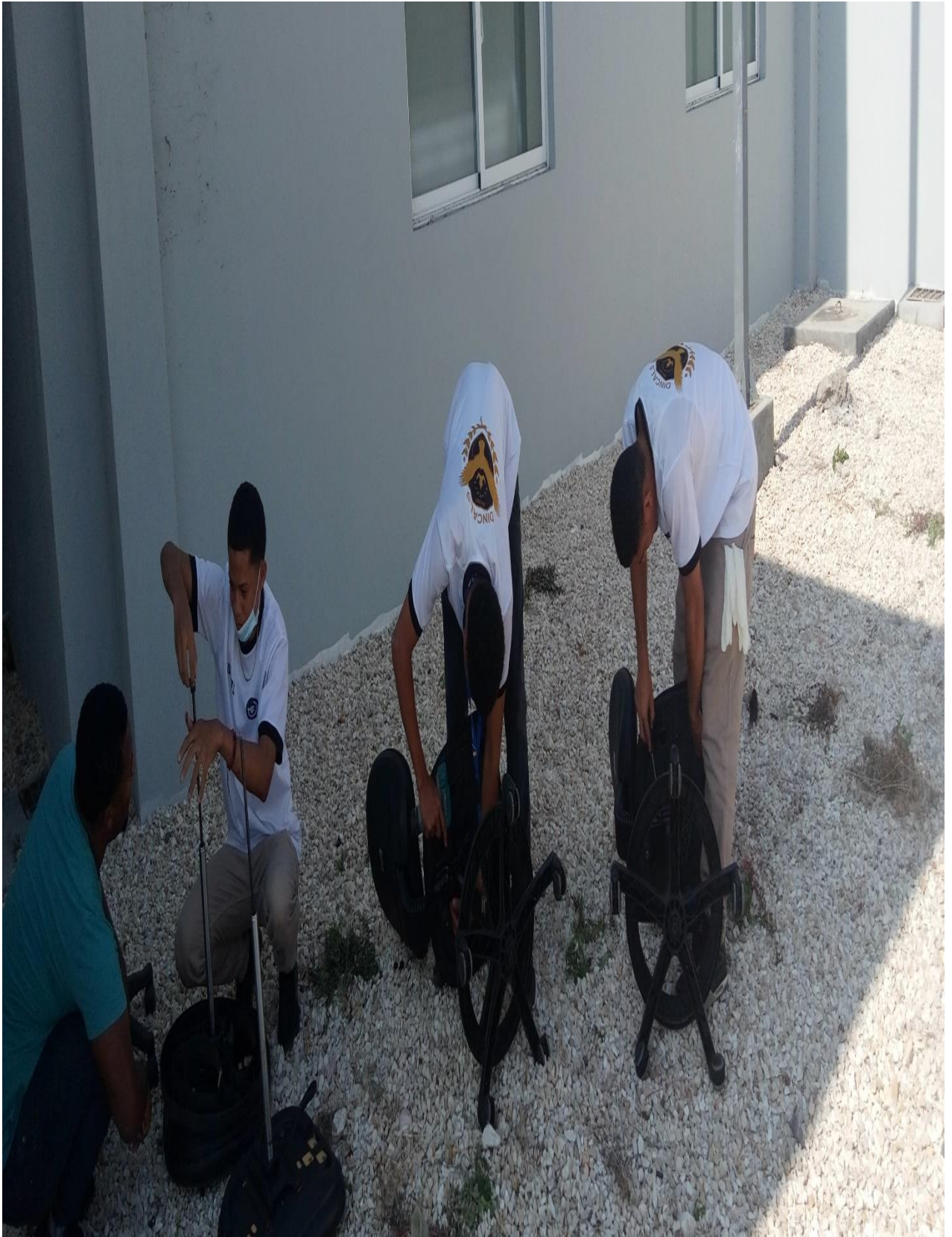
CAMBIO DE BAJANTE
