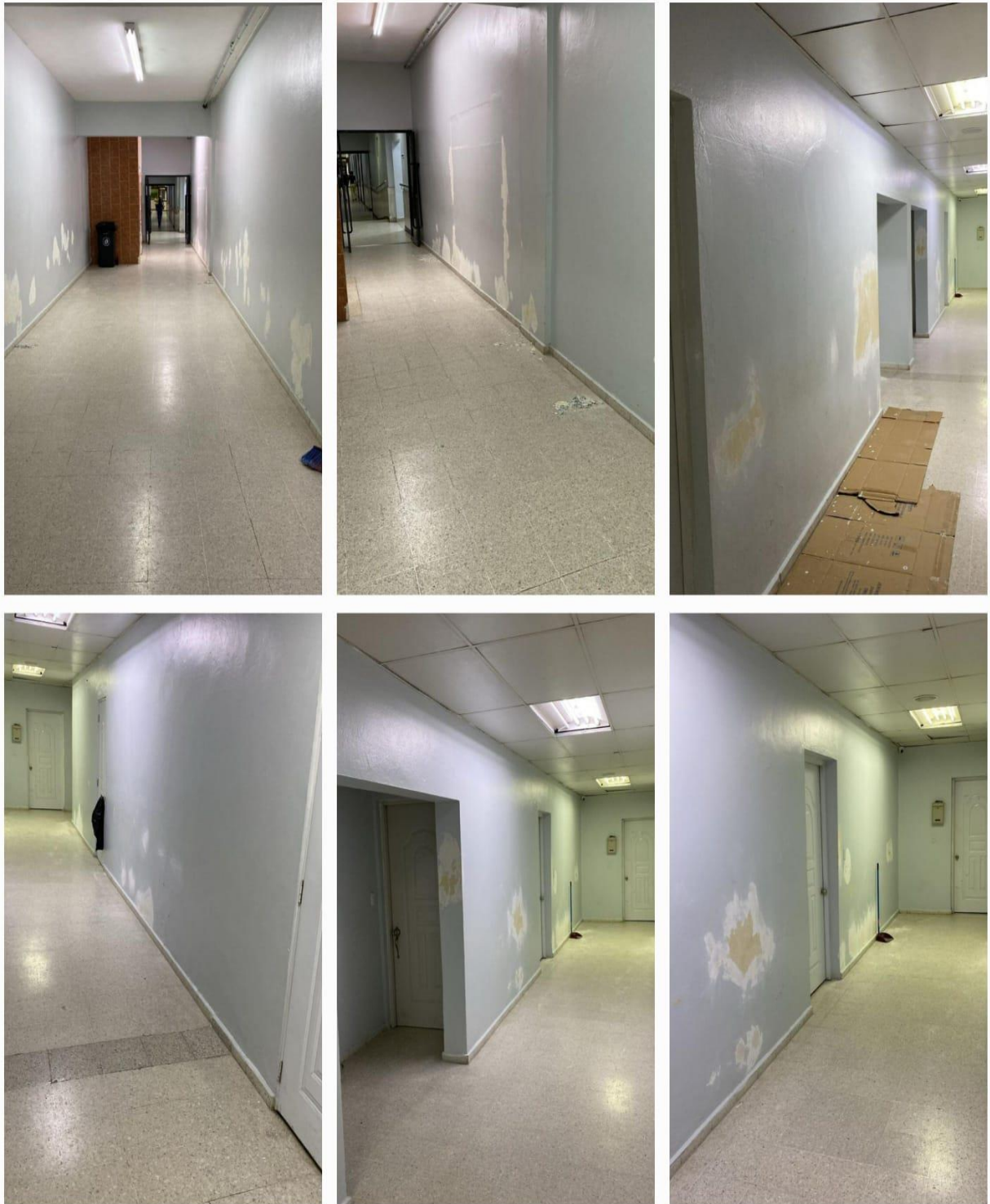
Pintura de Pasillos de Diferentes Áreas (Antes)
