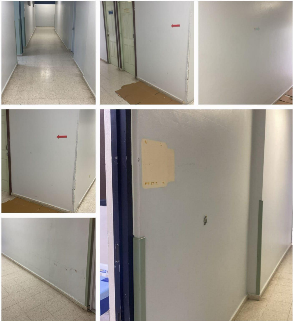
Pintura Pasillos Área de Maternidad (Antes)
