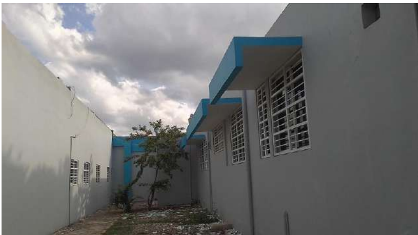
Pintura exterior Laboratorio
