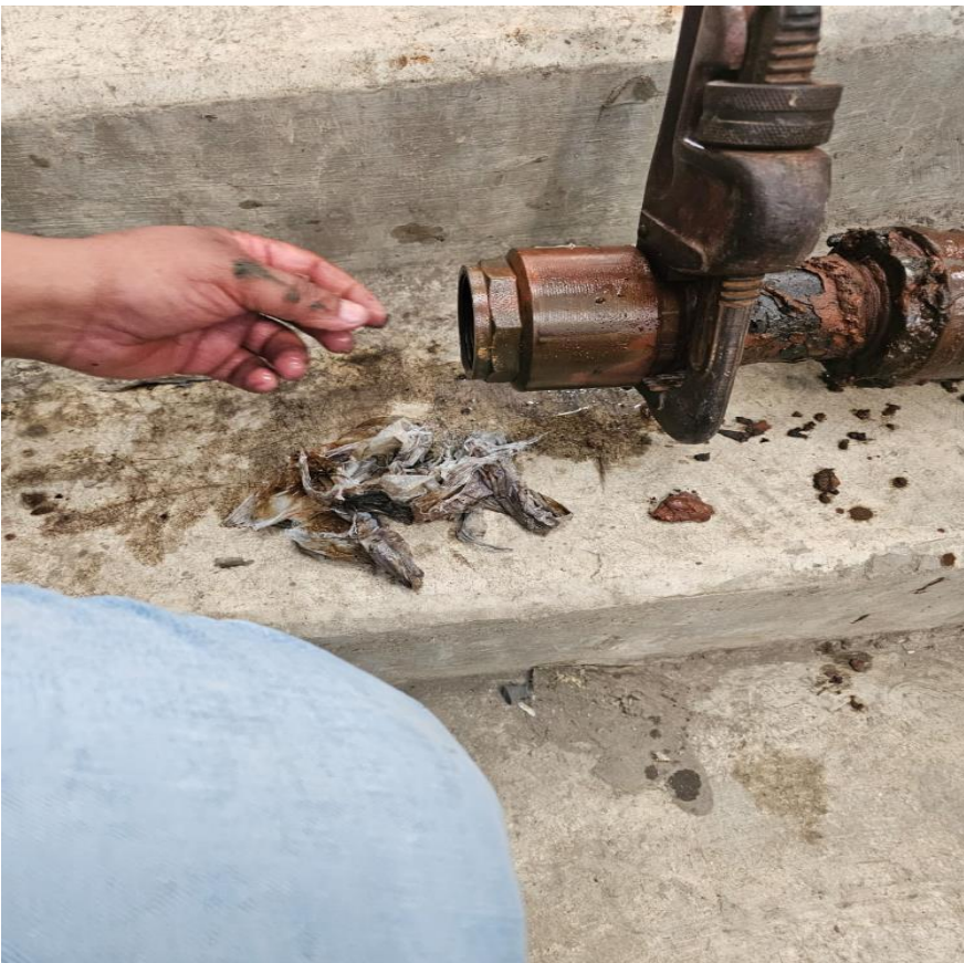
REPARACION TUBERIA DE ALTA PRESION BOMBA DE AGUA
