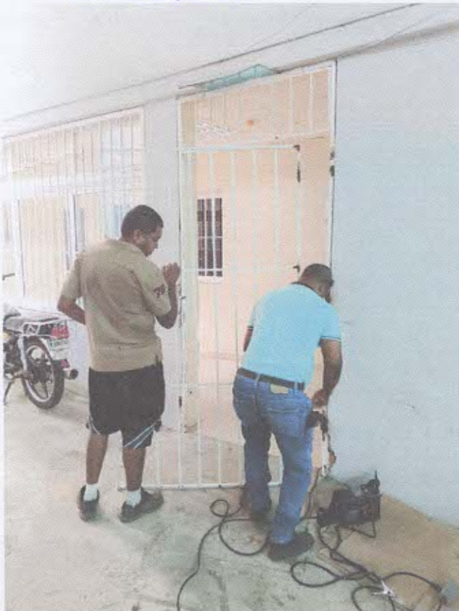
22/04/2024 Entrada al hospital
