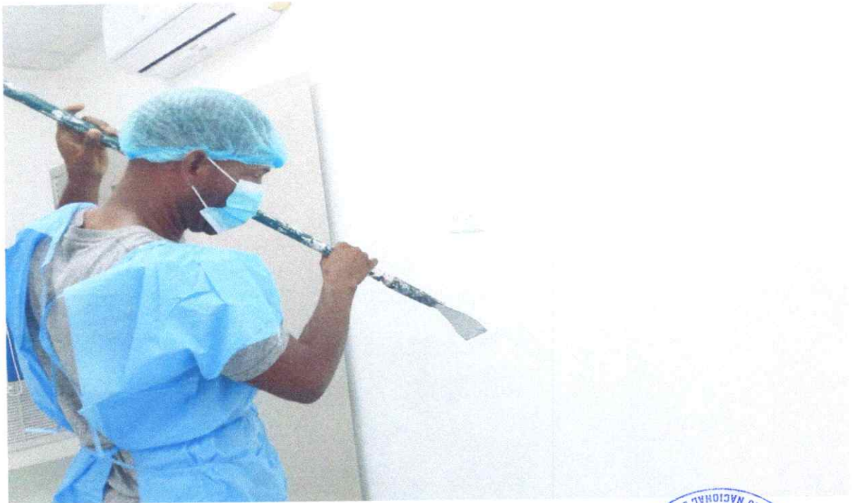
Revisión de pisos y pintura quirófano 1 agosto 2024
