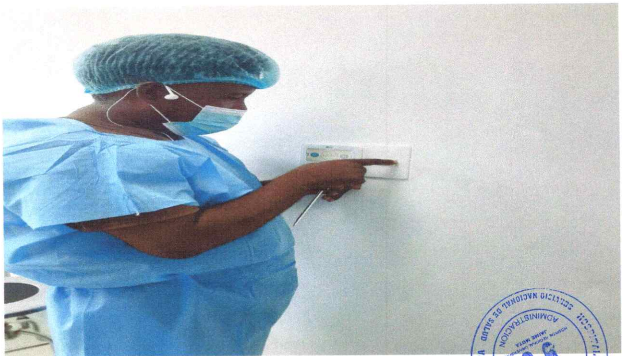
Revisión de interruptores lámparas y tomacorrientes
