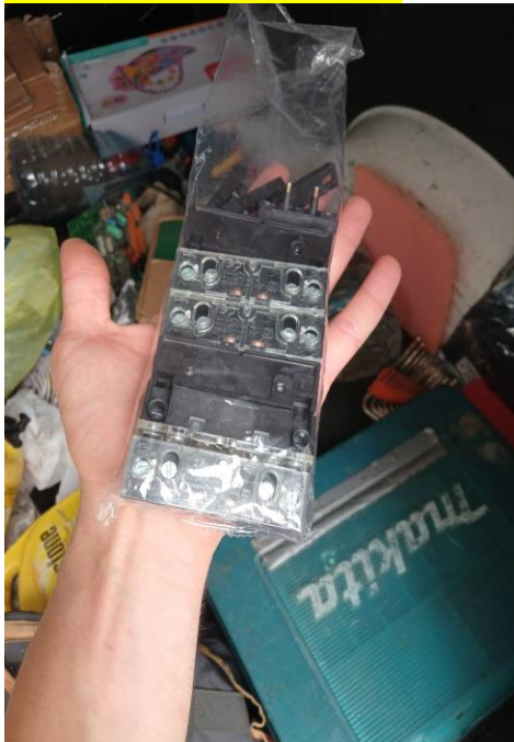
Contactos nuevos instalados
