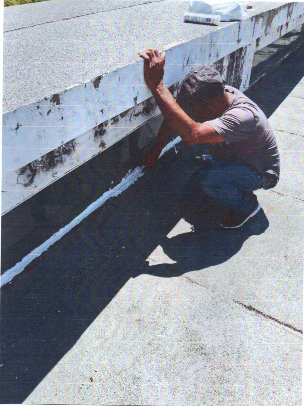
Reparación filtraciones del techo
