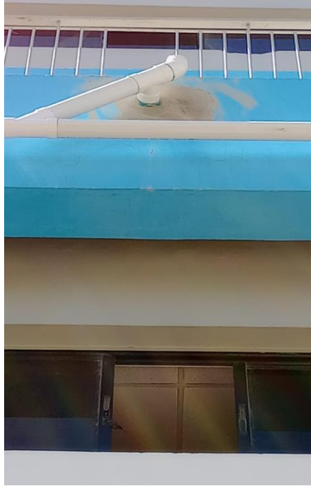
Parte de la nueva canalización de desagües instalados
