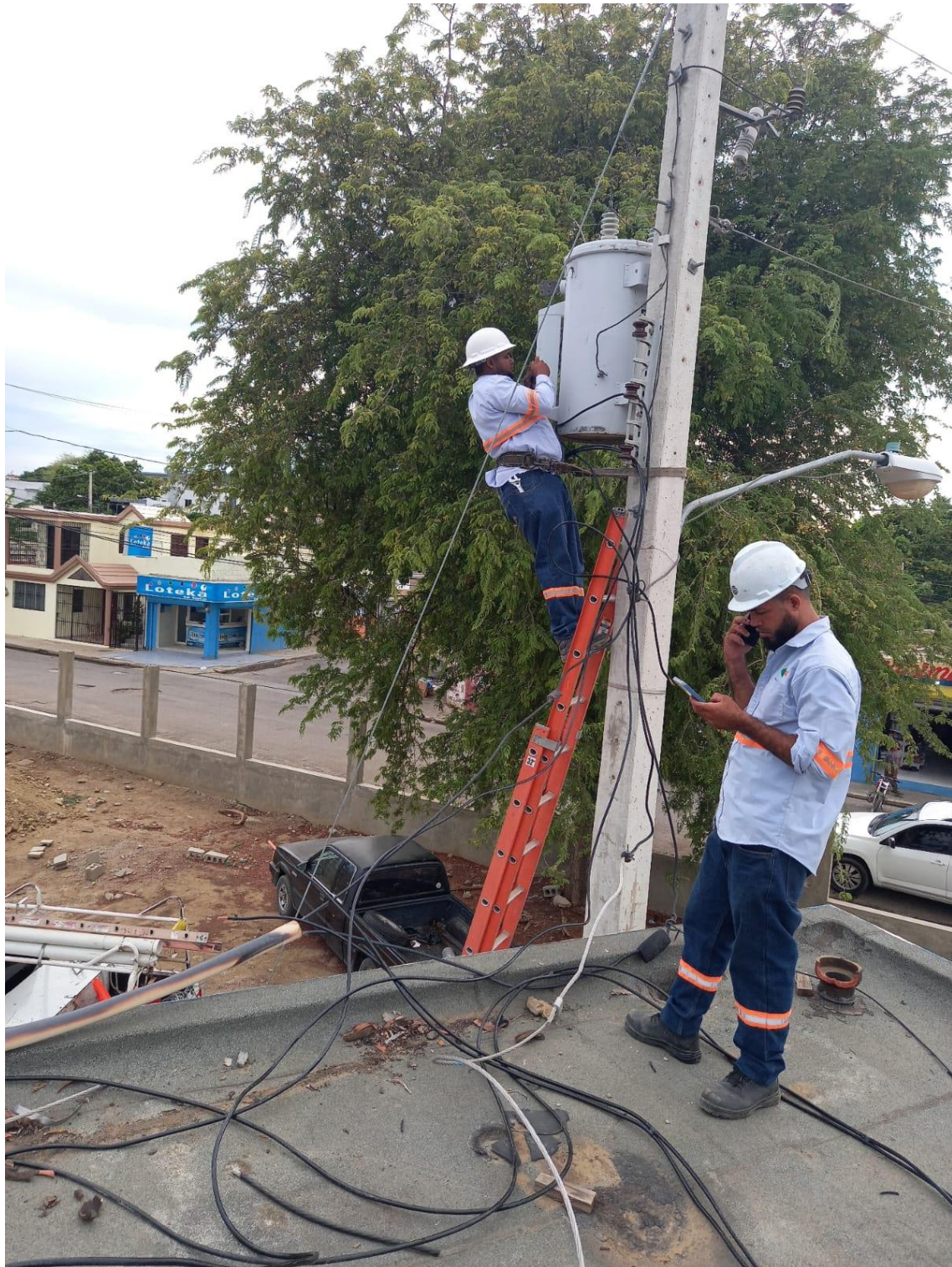
Reparación de cables eléctricos de la edificación, en fecha 14/08/2024
