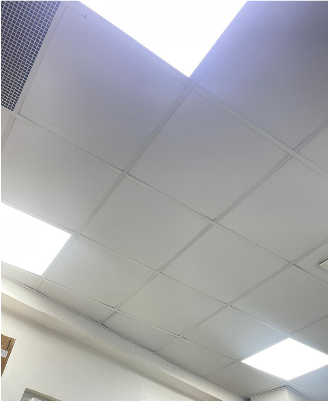
Imagen 25, techos sin filtraciones y buena iluminación.
