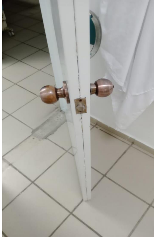
Cerradura nueva instalada
