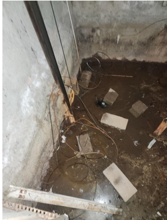
Cable nuevo instalado y el viejo
