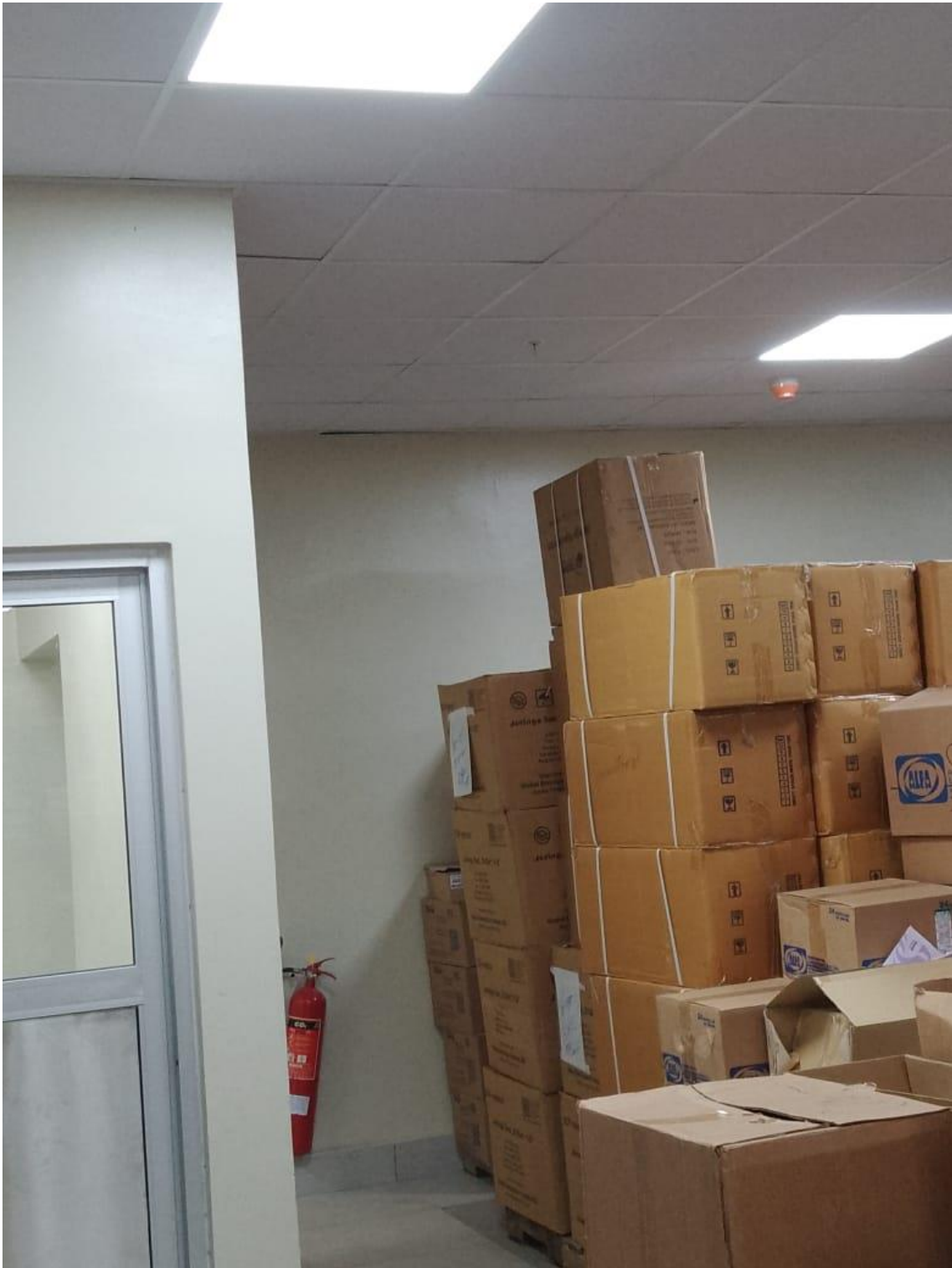
almacen,puertas, limpio, ordenado, espacio entre tramerias, tarimas, extintor a la vista
