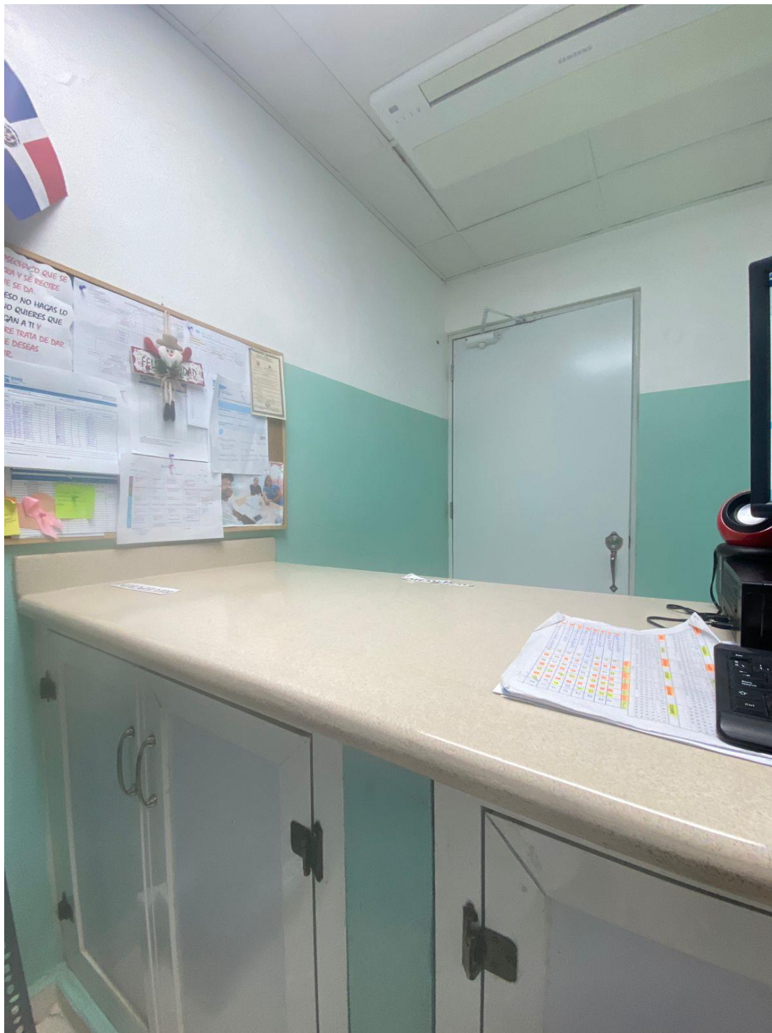
Ilustración 9. Se puede evidenciar la meseta para la preparación de los pedidos e identificación del área de Despacho
