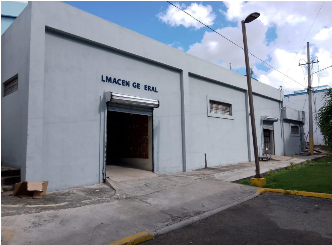
Parte frontal de Almacén General.
