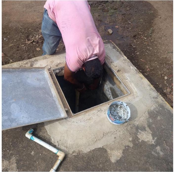
**Tapada de filtración paredes de la cisterna y cambio de posición de la flota de dicha cisterna, en fecha 17/01/2025**
