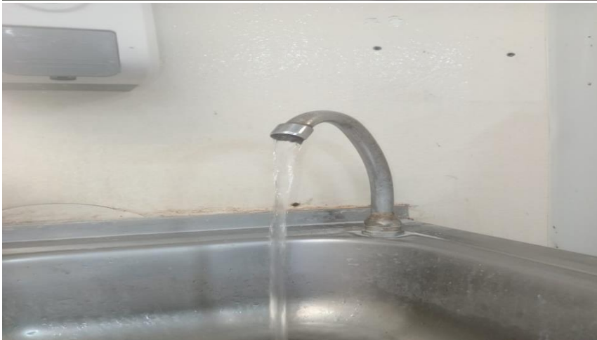
REVISION Y REPARACION DE LAVAMANOS
