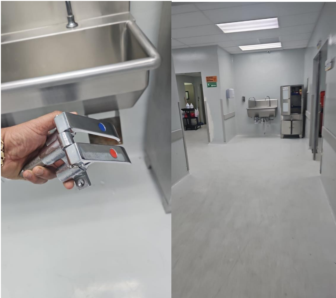
INTALACION DE PEDAL PARA LAVAMANOS
