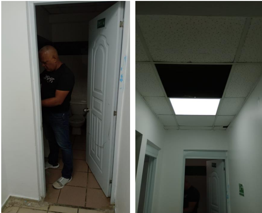
Instalación de energía eléctrica cuarto de la bomba y morgue, colocación de bombillo.
