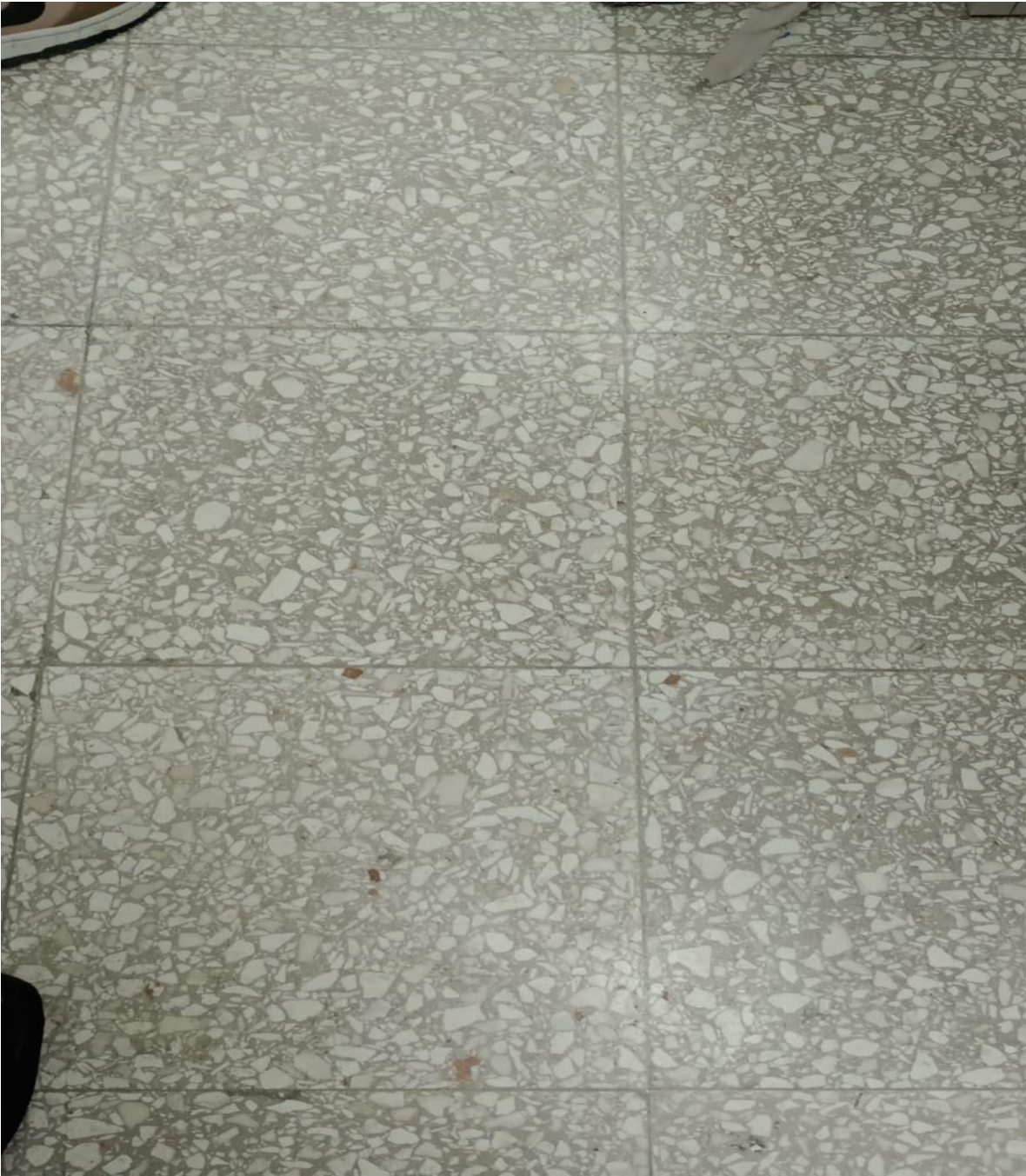
#1. Cambio de Cerámicas en Oficinas Administrativas Febrero 2025
