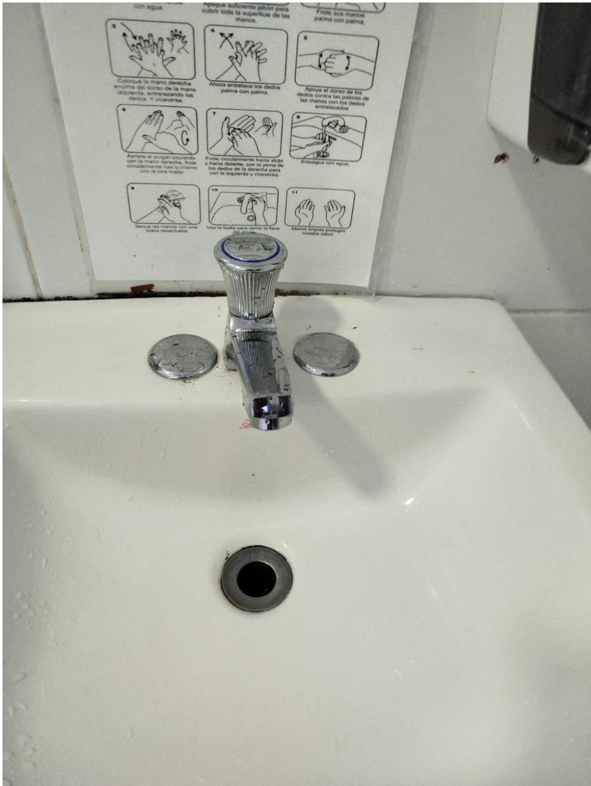
#7. Cambio de Lavamanos Febrero 2025
