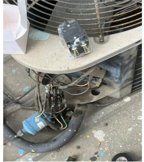
**Aire de emergencia: piso techo** realizo mantenimiento correctivo, cambió el capacitor quemado.
