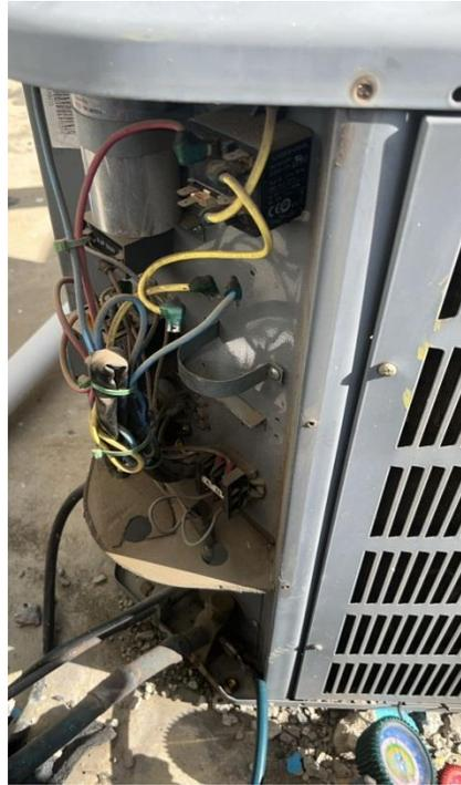
**Aire de farmacia interna:** se realizó revisión y mantenimiento preventivo, el aire se le quemo el breaker.
