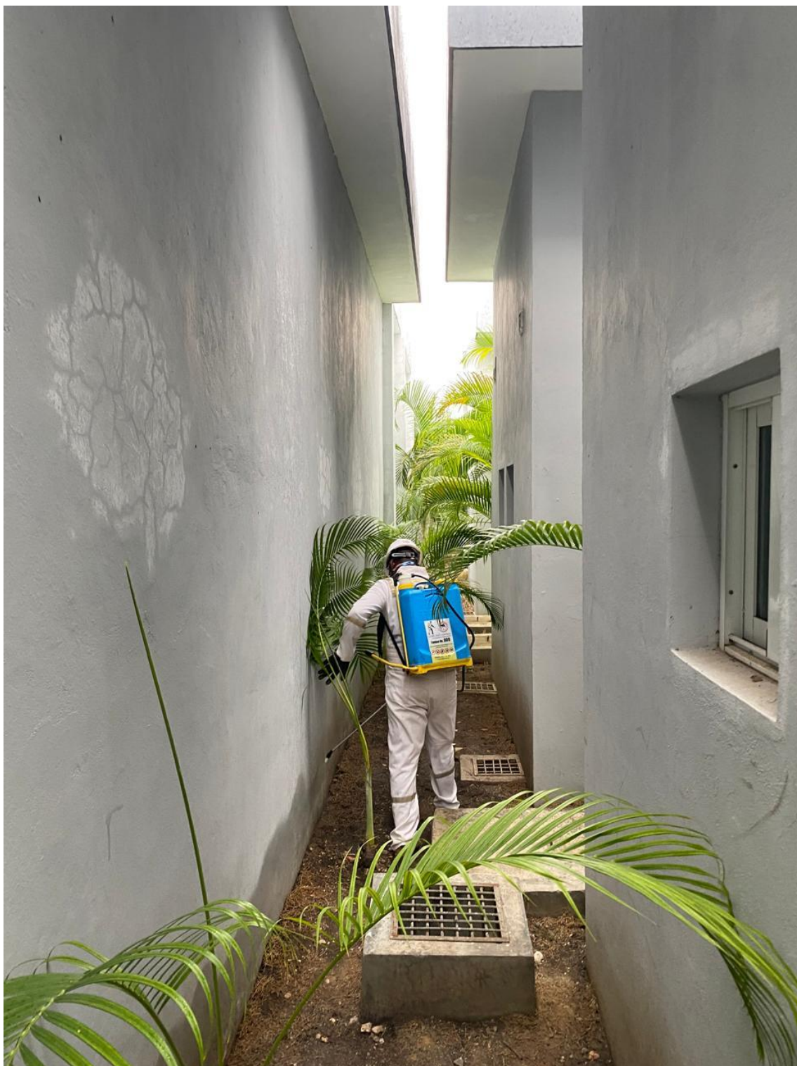
Fumigación en el exterior del hospital 15/02/2025.
