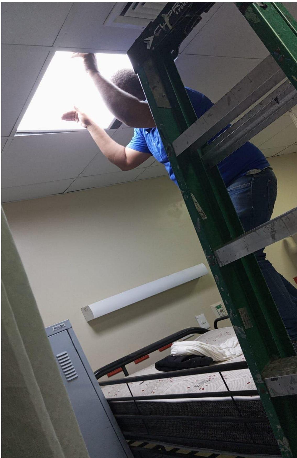
Mantenimiento correctivo cambio de lámpara 2x2 led descaso de enfermería. 10/03/2025
